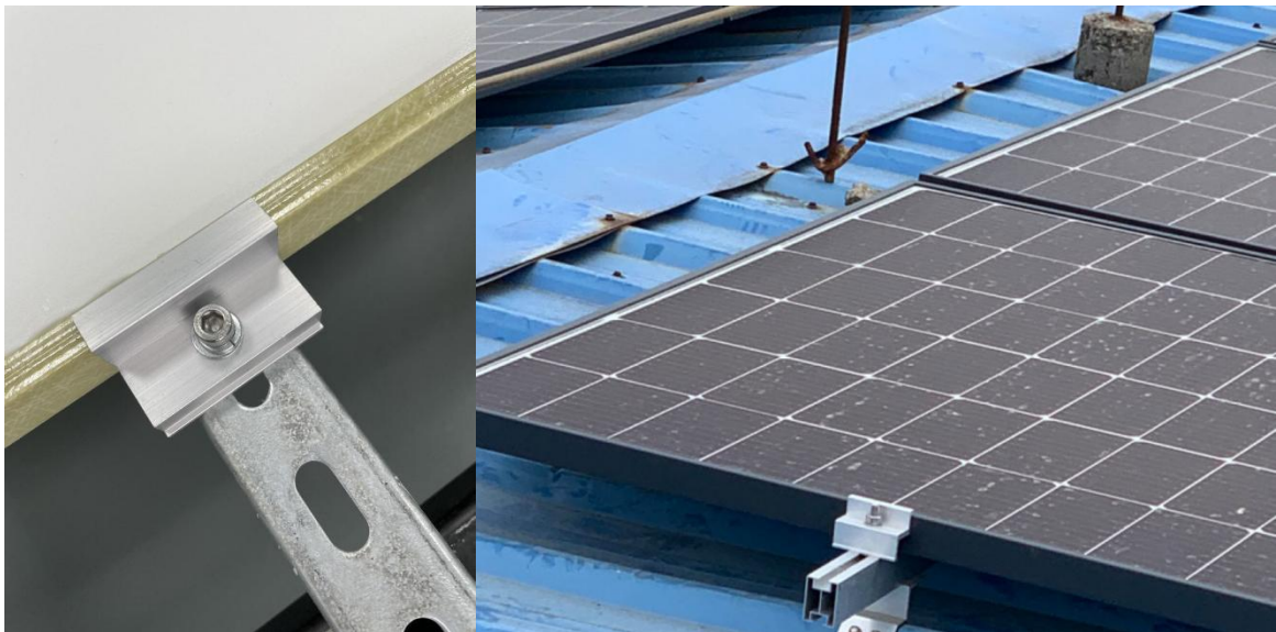
图 2.2 特殊压块安装实拍图
