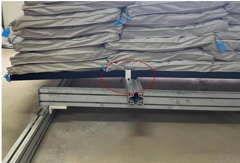
图 3.2 C 型螺栓安装实拍图
